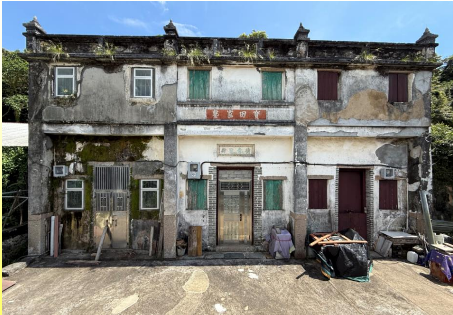
建築物的外部 Exterior of the building
